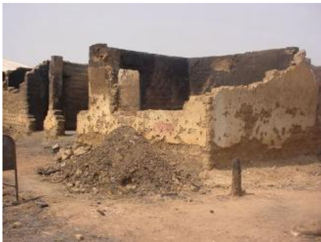
Une partie du village complètement détruite par les flammes
