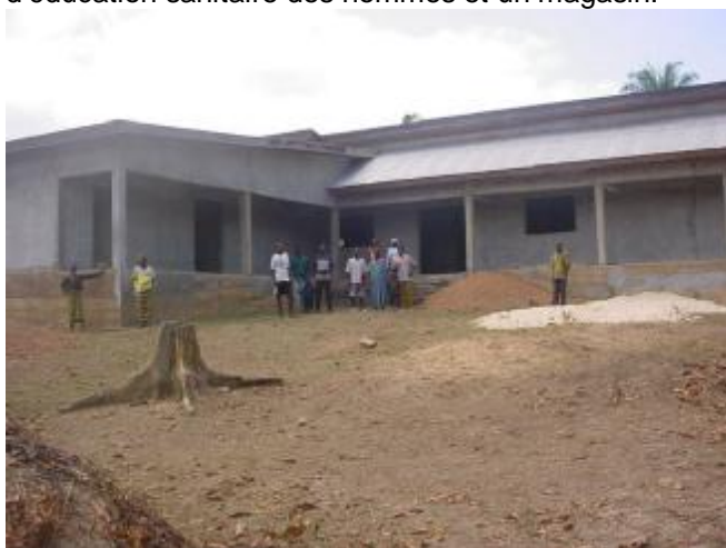
Le poste de santé de Zinigrozou en construction
