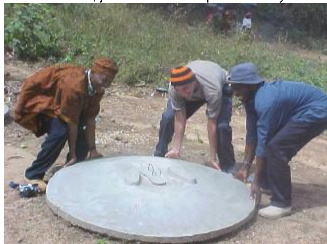
Le Coordinateur de la zone Sud, Marcus et Abdourahamne KABA déposent la dalle sur une latrine à Bowé
