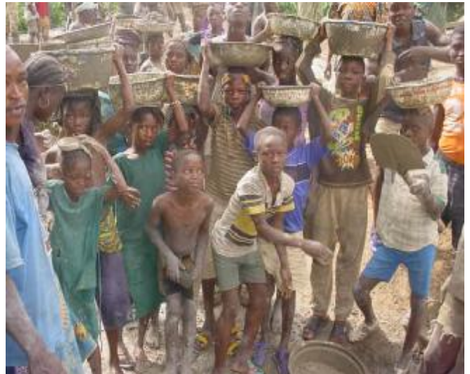
Les enfants du district de Iyezou, Fassankony avec le béton en tête lors du coulage d'un pont le 29 juin
