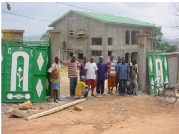
La DPE de Guéckédou avant les derniers travaux
