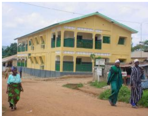
Le bloc administratif de l'hôpital de Gueckédou
